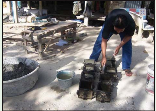
รูปที่ 5-30 เก็บตัวอย่างคอนกรีต เพื่อทดสอบกำลังอัด
