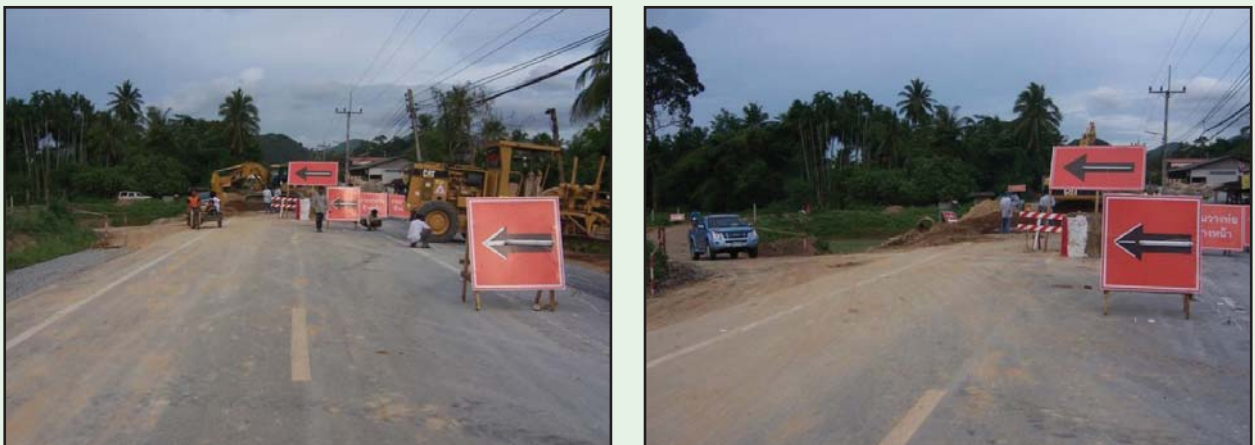
รูปที่ 5-19 แสดงการติดตั้งป้ายเตือนและไฟฟ้แสงสว่างที่บริเวณก่อสร้าง
