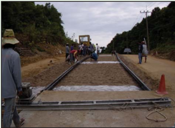
รูปที่ 6-54 ทุกรอยต่อต้องวางแผ่นรองกันชื้น
