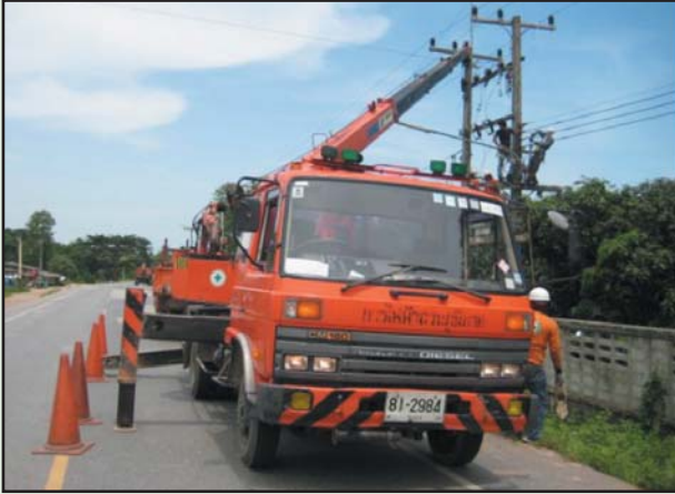
รูปที่ 2 - 2 การดำเนินการย้ายสาธารณูปโภคออกจากเขตก่อสร้าง
