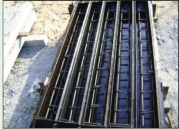
ตรวจสอบแบบหล่อ
