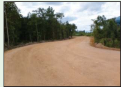
รูปที่ 4-40 ชั้นรองพื้นทางที่แล้วเสร็จต้องมีความเรียบและได้ระดับตามแบบแปลน
