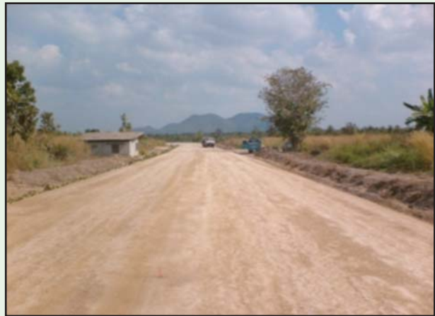
รูปที่ 4-32 งานก่อสร้างแล้วเสร็จจะต้องมีระดับความกว้าง ความยาวและความแน่นตามแบบแปลน
