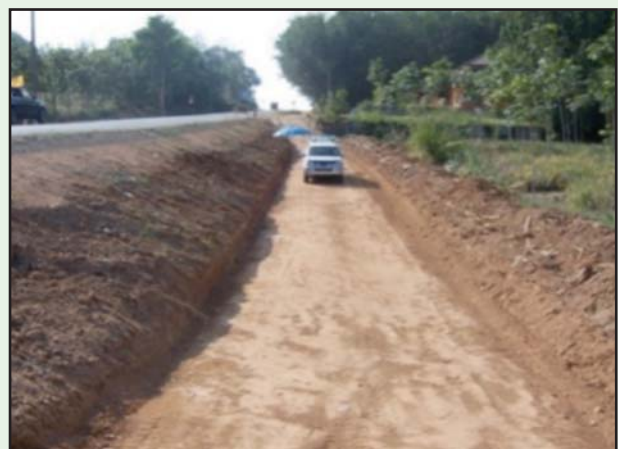
รูปที่ 4-16 หลังจากการบดอัดแต่ละชั้น ทำการทดสอบความแน่น
