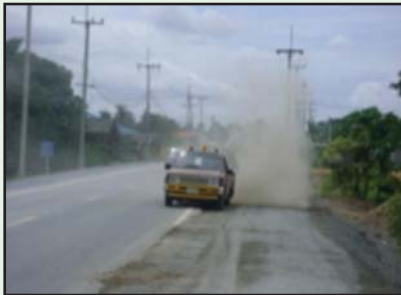
รูปที่ 6-2 กวาดทำความสะอาด
