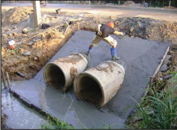
รูปที่ 5-39 การแต่งผิวหน้าคอนกรีตให้เรียบ
