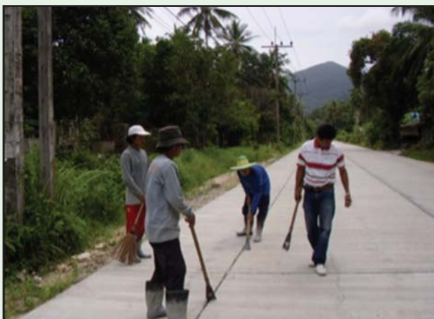
รูปที่ 6-66 กวาด ทำความสะอาด หรือใช้ลมเป่ารอยต่อ ก่อนหยุดอย่าง
