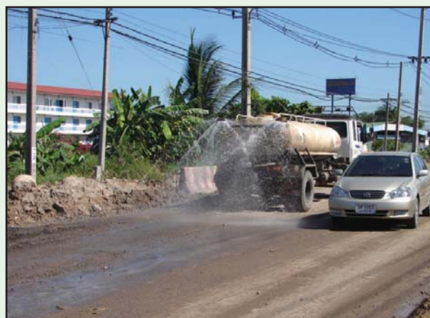
รูปที่ 8-11 การจัดให้มีทางสัญจรแก่ประชาชนขณะทำการก่อสร้าง
