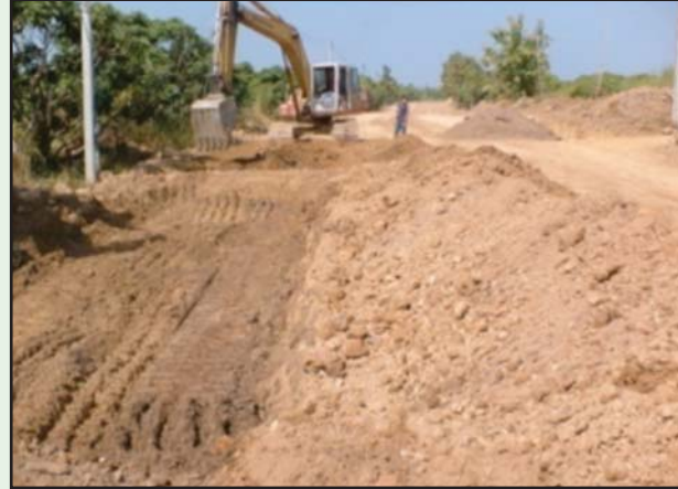
รูปที่ 4-29 การขุดตัดวัสดุที่ไม่ต้องการและนำไปทิ้งในที่ที่เหมาะสม
