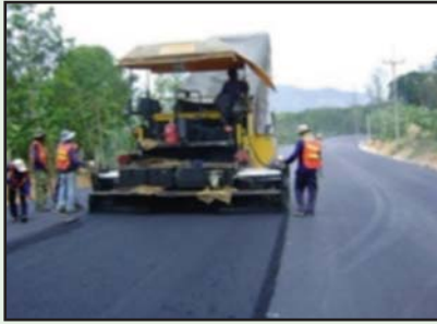
ควบคุมความสม่ำเสมอขณะปู
