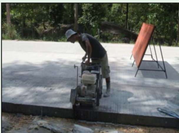
รูปที่ 6-62 ตัด Joint ภายใน 8 ชั่วโมงหลังจากเทคอนกรีต
