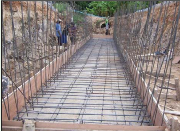
รูปที่ 5-22 การเข้าแบบหล่อและการเสริมเหล็ก พื้นล่างท่อเหลี่ยม
