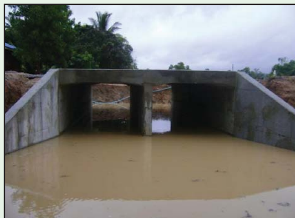
รูปที่ 5-17 ลักษณะท่อเหลี่ยมที่ก่อสร้างแล้วเสร็จ
