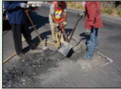
รูปที่ 6-24 แต่งพื้นที่เสียหายและปะซ่อมเสริมให้ได้ระดับ
