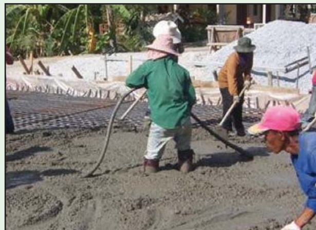
รูปที่ 5-28 (ข) การจี้คอนกรีตขณะเทคอนกรีต
