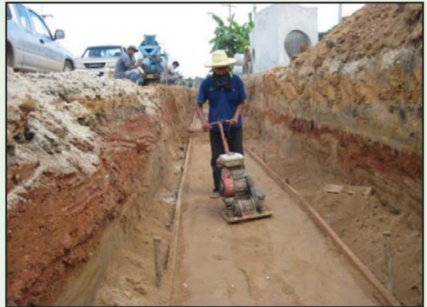
รูปที่ 5-10 การบดอัดดินให้แน่นก่อนเทคอนกรีตหยาบรองรับท่อ
