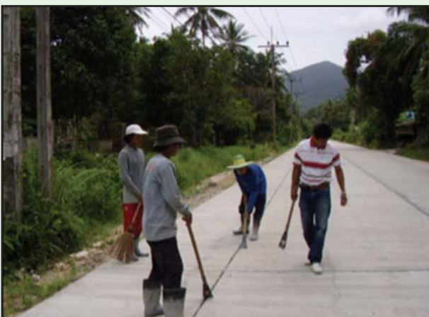
รูปที่ 6-66 กวาด ทำความสะอาด หรือใช้ลมเป่ารอยต่อ ก่อนหยอดยาง
