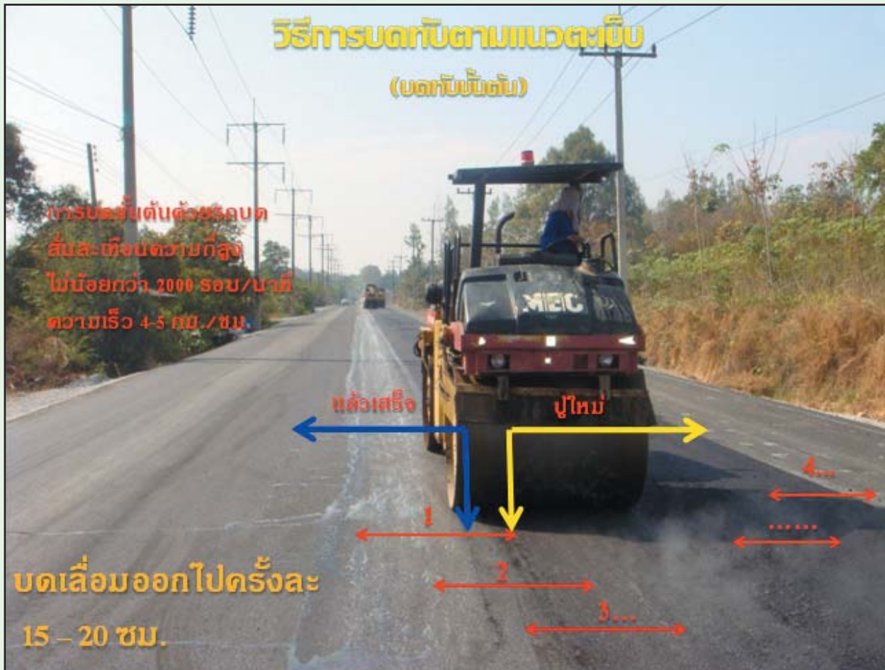
รูปที่ 6-33 วิธีการบดทับตามแนวตะเข็บ
