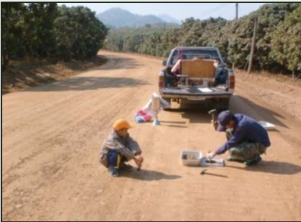
รูปที่ 4-31 การทดสอบความแน่นโดยวิธีทรายถมแทนที่
