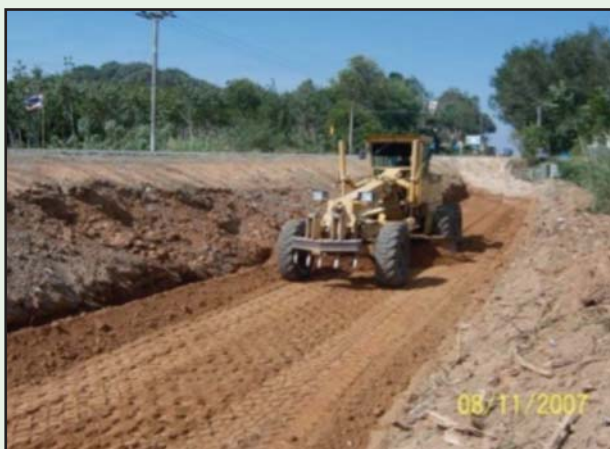
รูปที่ 4-15 ขุดคู้ (Scarify) พื้นทางเดิม
