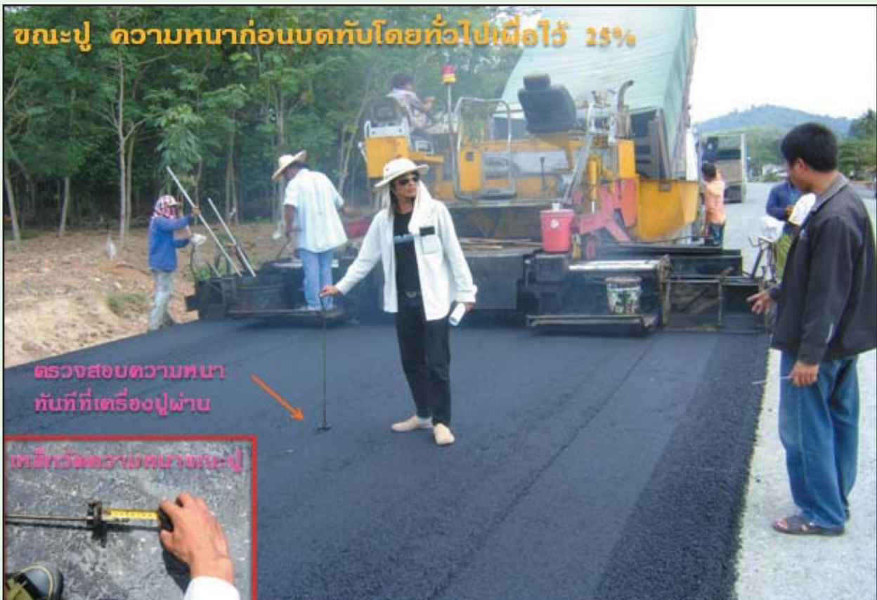
รูปที่ 6-30 แสดงการตรวจสอบความหนาขณะปูแอสฟัลต์คอนกรีต
