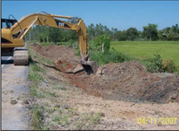
รูปที่ 4-29 การขุดตัดวัสดุที่ไม่ต้องการและนำไปทิ้งในที่ที่เหมาะสม
