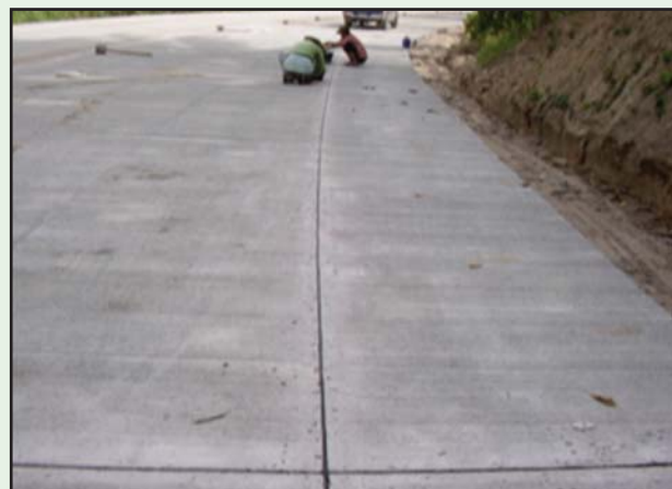
รูปที่ 6-66 กวาด ทำความสะอาด หรือใช้ลมเป่ารอยต่อ ก่อนหยุดอย่าง
