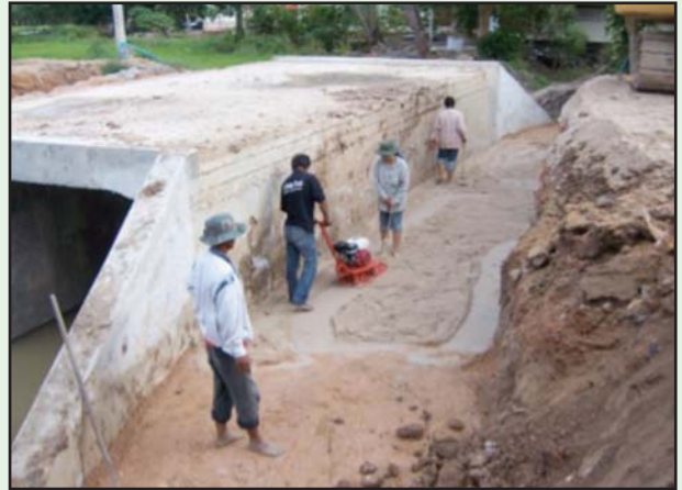
รูปที่ 4-21 การบดอัดความแน่นบริเวณ ด้านข้างท่อเหลี่ยม
