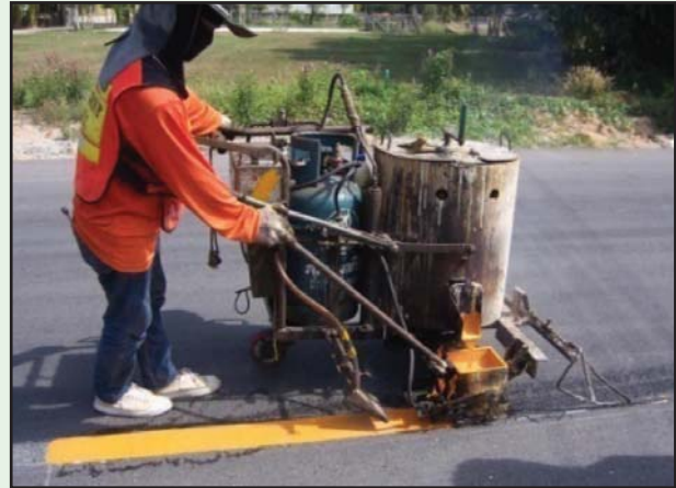
ทำการทาสีด้วยเครื่อง ที่ควบคุมอุณหภูมิได้
