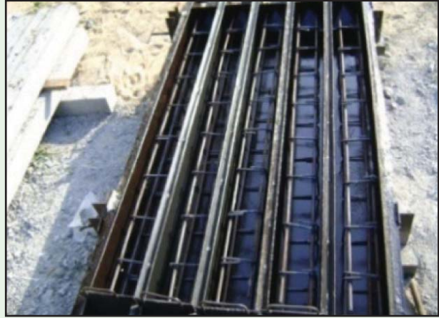
ตรวจสอบแบบหล่อ
