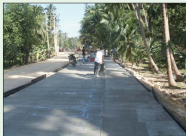
รูปที่ 6-62 ตัด Joint ภายใน 8 ชั่วโมงหลังจากเทคอนกรีต
