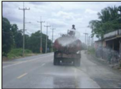
รูปที่ 6-3 ฉีดล้างทำความสะอาด
