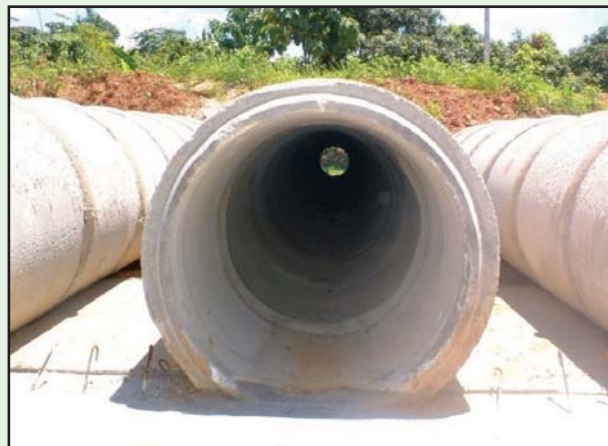
รูปที่ 5-37 การเทคานหน้าท่ออาจทำในขั้นตอนการเทคอนกรีตหยาบรองท่อก็ได้
