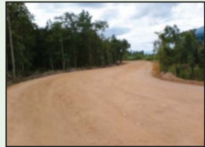
รูปที่ 4-40 ชั้นรองพื้นทางที่เสร็จแล้วเสร็จต้องมีความเรียบและได้ระดับตามแบบแปลน
