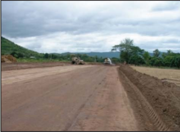
พื้นทางเดิมที่บดอัดแล้ว
