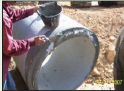
รูปที่ 5-12 การสอบปูนภายในปากท่อในขณะวาง
