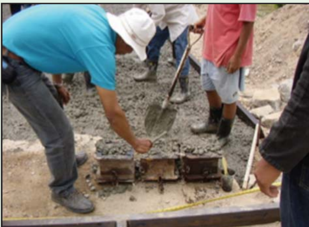
รูปที่ 6-55 การเก็บตัวอย่างคอนกรีตเพื่อทดสอบ
