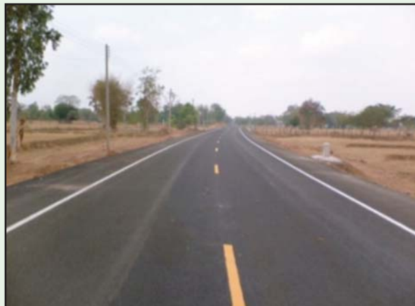
รูปที่ 6-46 ภาพงานก่อสร้างผิวทางเคพซีลแล้วเสร็จ
