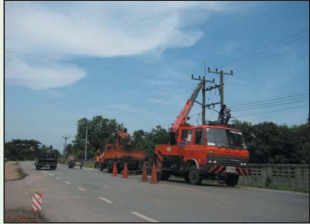
รูปที่ 2 - 2 การดำเนินการย้ายสาธารณูปโภคออกจากเขตก่อสร้าง
