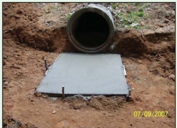
รูปที่ 5-11 เทคอนกรีตหยาบรองรับท่อ
