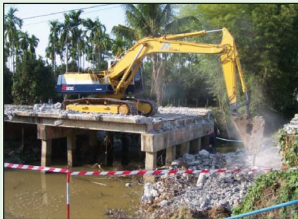
รูปที่ 5-21 การกั้นขอบเขต เพื่อทำการรื้อถอนโครงสร้างเดิม
