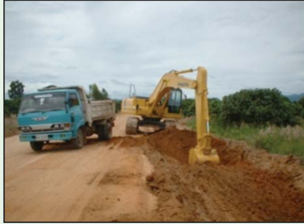
รูปที่ 4-17 การขุดวัสดุที่ไม่เหมาะสมออกในบริเวณ Soft Spot
