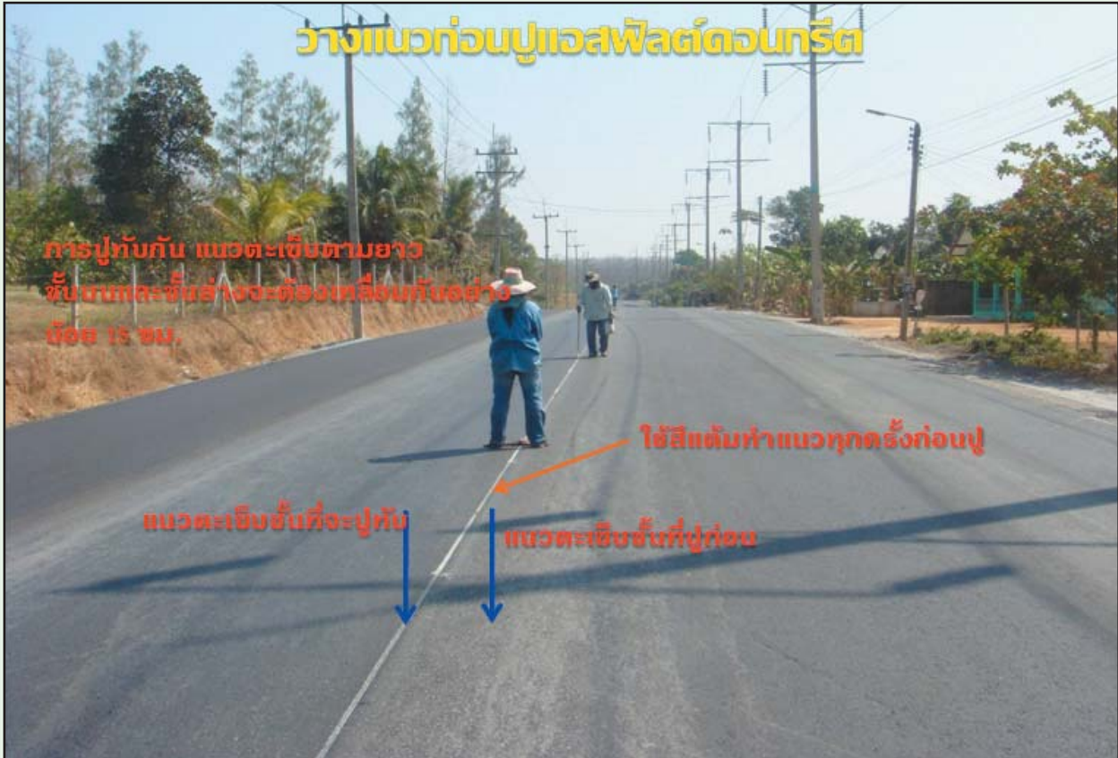
รูปที่ 6-29 แสดงการวางแนวเกลี่ยปูแอสฟัลต์คอนกรีตชั้นถัดไป
