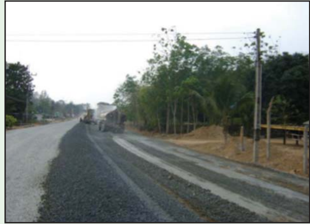
รูปที่ 4-46 การผสมและบดอัดหินคลุก
