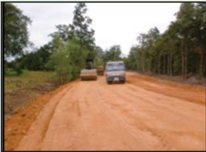
รูปที่ 4-38 การคลุกเคล้าผสมและบดอัดชั้นรองพื้นทาง
