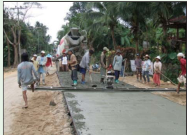
รูปที่ 6-58 ใช้ Front Screen ปาดแต่งผิวคอนกรีตให้ได้ระดับ
