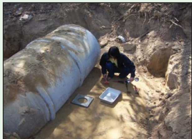
รูปที่ 5-14 ให้ทดสอบความแน่นข้างท่อทุก ๆ ชั้น
