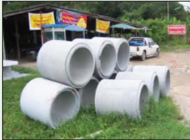
รูปที่ 8-7 การกองวัสดุจะต้องคำนึงถึงความปลอดภัยของผู้ใช้เส้นทาง
