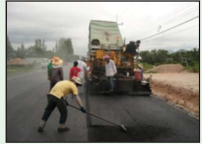
ควบคุมแนวการปู
